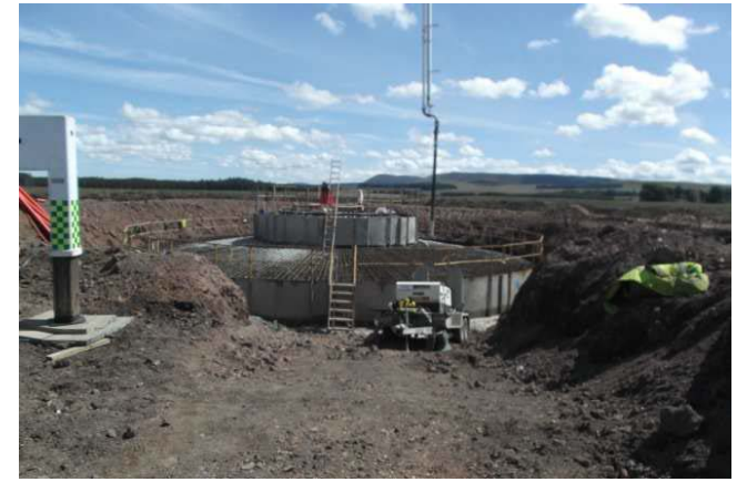
Concrete pour at WTG22
